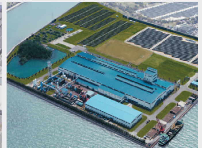
詫間工場 Takuma Plant **
