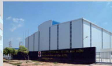
5 Maruichi Sun Steel (Hanoi) Co., Ltd.
