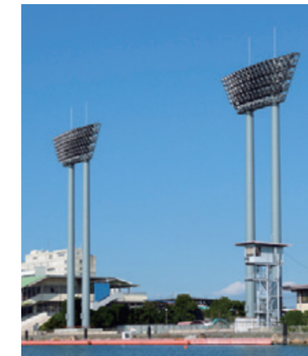
照明鉄塔 Lighting Tower
