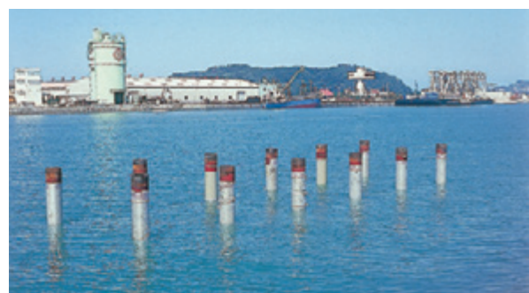
鋼管ぐい Pipe Piling
