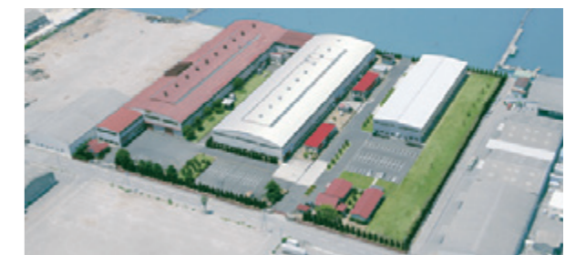
四国工場 Shikoku Plant **
