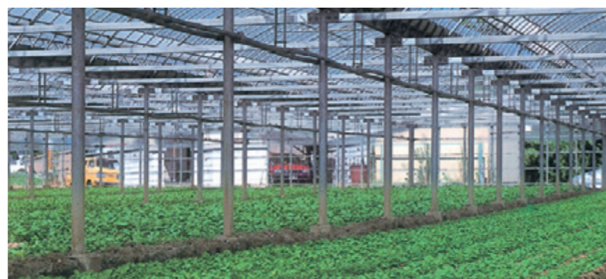
大型ハウス Green House Framing
