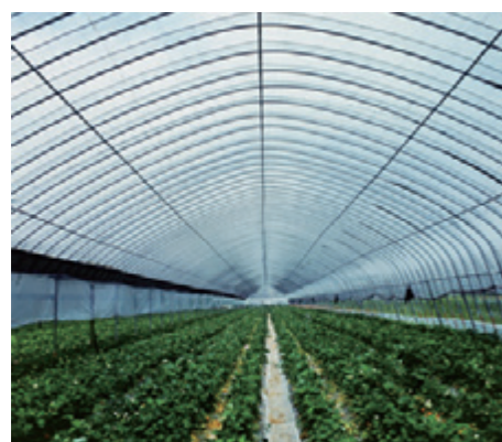
グリーンハウス Green House Framing
