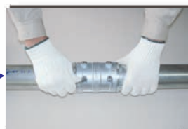
締め付ボルトで固定する
