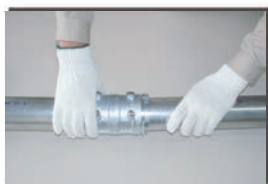
管を差し込む
