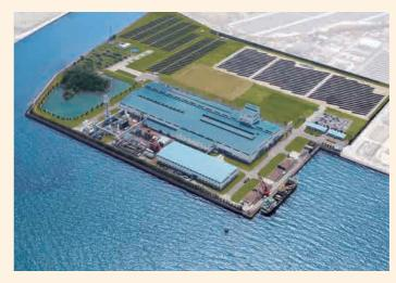
詫間工場は、最新の技術を集結して完成された鋼帯処理工場であります。高炉 メーカーの熱延コイルが酸洗、冷延、焼鈍工程を経て、溶融亜鉛めっきコイル及 び冷延コイルが生産されます。これらの製品は丸ーグループの各工場に送られ て高品質のプレジンク鋼管や機械構造用鋼管に加工されます。
