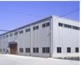
丸一鋼管 (株) の名古屋新倉庫およびパイプセンター
