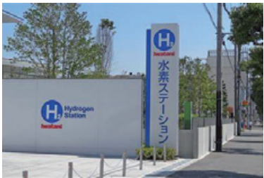
水素ガスステーション (提供: 岩谷産業株式会社)
